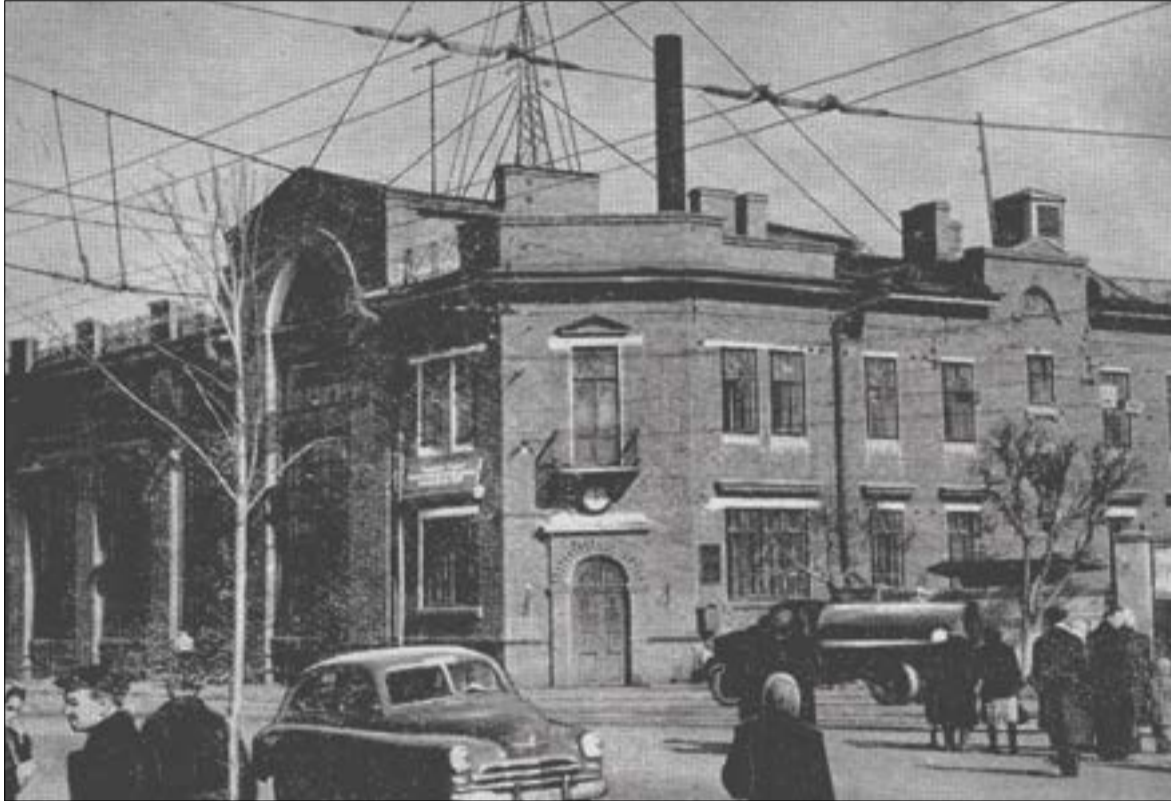
Здание электростанции им. III годовщины ТАССР
