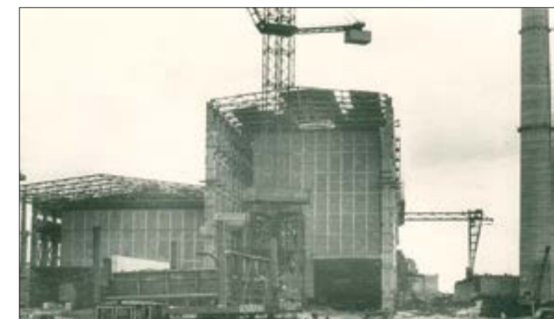
Строительство Заинской ГРЭС
