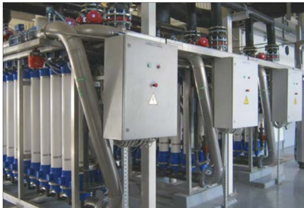
Рисунок 2. Установка микрофильтрации Казанской ТЭЦ-2
