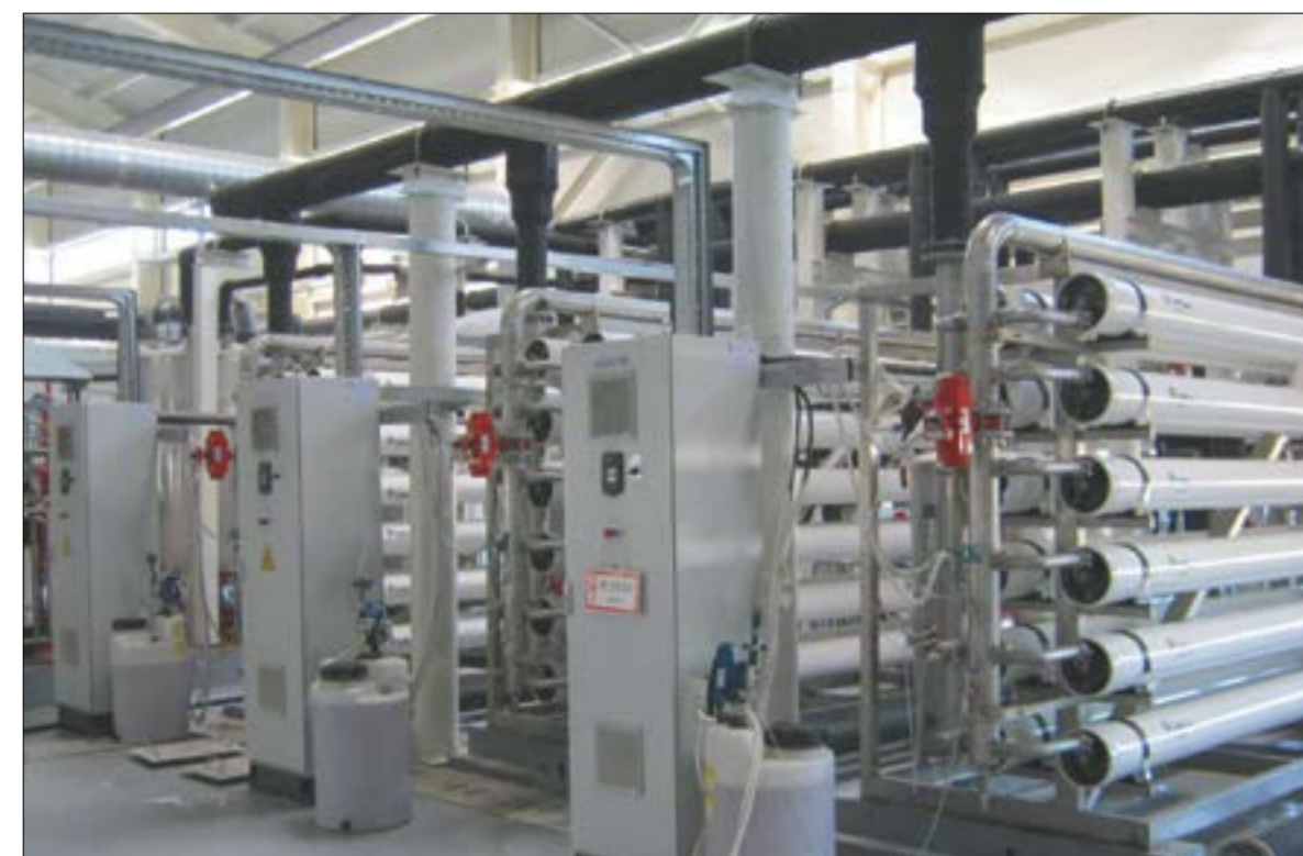
Рисунок 3. Установка обратного осмоса Казанской ТЭЦ-2
