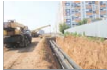
Плюс 31 километр Примем бесхозные сети Набережных Челнов
