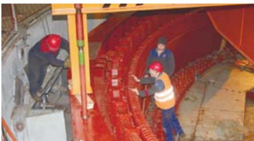
гидроагрегата; центровку статора относительно ротора.
