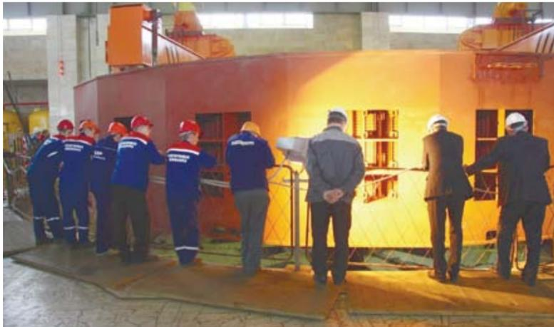
Работы, проведенные на роторе гидрогенератора, существенно снизили величины виброперемещений верхней крестовины и биения вала в районе генераторного подшипника и довели их до приемлемых значений в режимах работы не выше 40 МВт. Работы, выполненные на роторе генератора, существенно снизили вибрацию и на сердечнике статора (максимальные размахи виброперемещений сердечника статора были уменьшены почти в два раза) но, тем не менее, остались более чем в два раза выше допустимых значений.
