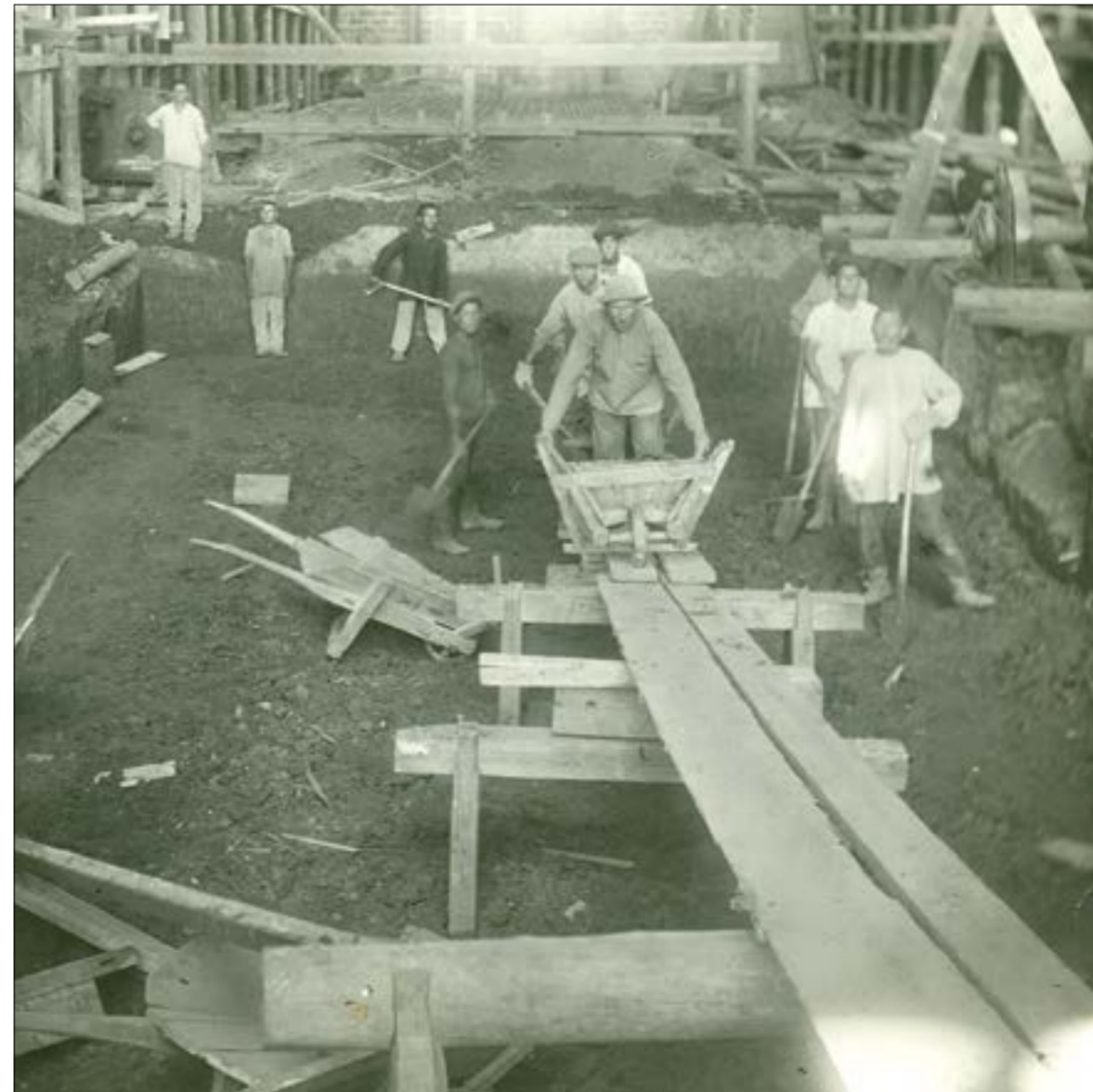
Казанская ТЭЦ-1. Строительство котлована. 1931 год
